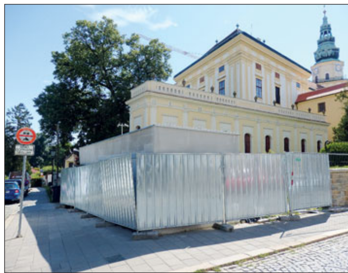
Snímen zachycuje pohled na místo v blízkosti Arcibiskupského zámku Kroměříž, kde je nová trafostanice, vyvolávající nesouhlasné reakce.
