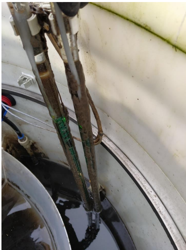
Obrázek 8 Zanesená kalová sonda
