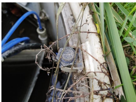
Obrázek 4 Znečištěné víko – lišejník, tráva
