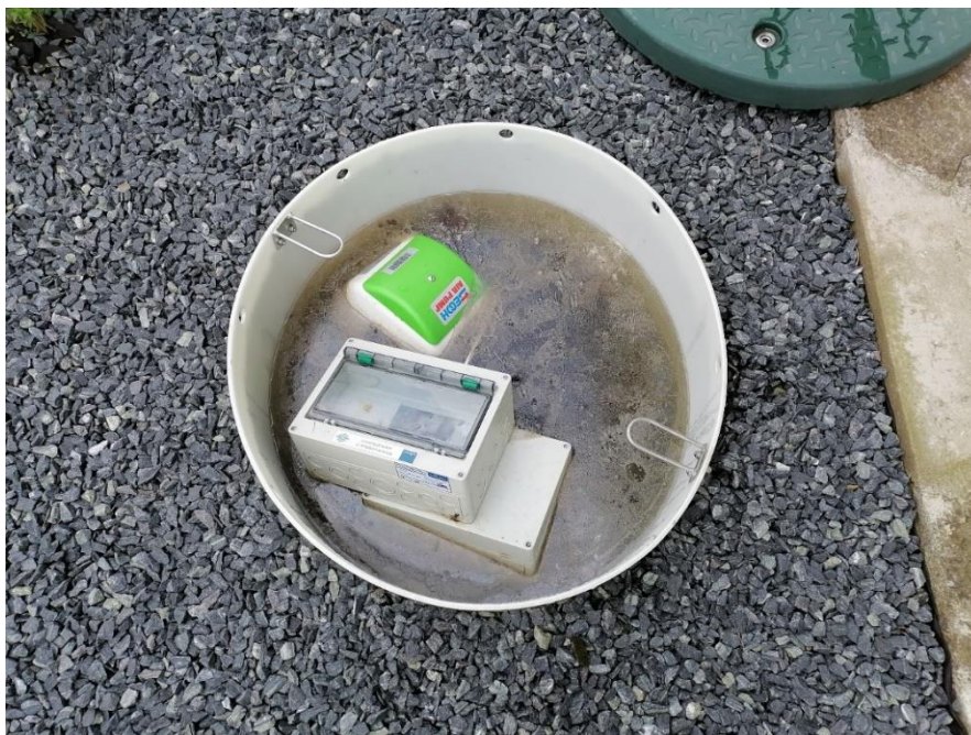
Obrázek 11 Vytopení technologické šachty s dmychadlem a řídicí jednotkou
