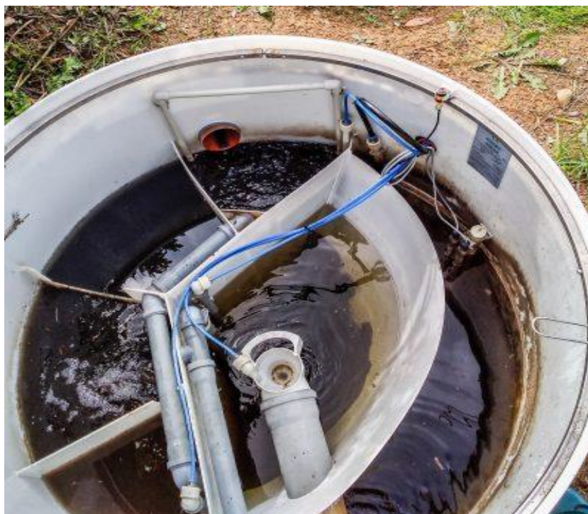
Obrázek 9 Zatopená ČOV přečištěnou vodou z retenční nádrže
