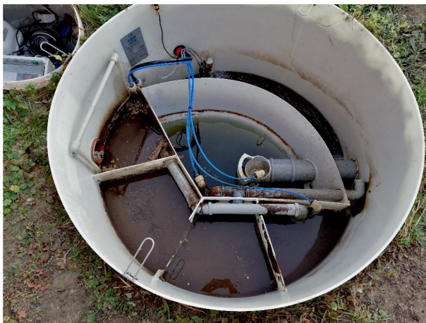
Příklad umístění kalového čidla v ČOV
