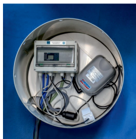
Příklad umístění řídicí jednotky u ČOV
