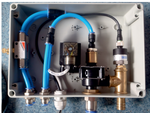
Rozváděč vzduchování - analogové čidlo
