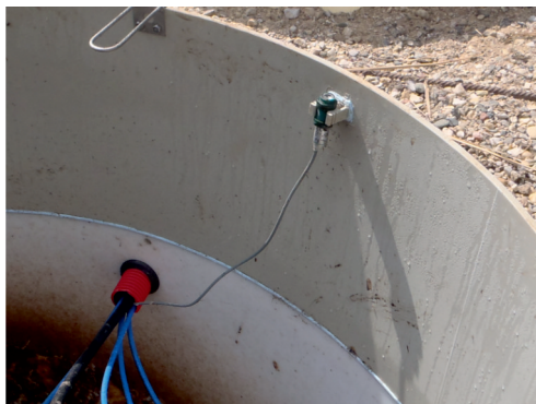
Příklad umístění čidla v ČOV
