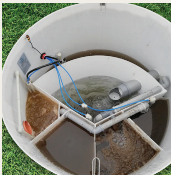
Domovní čistírna s technologickým blokem v obci Rybí ▲
