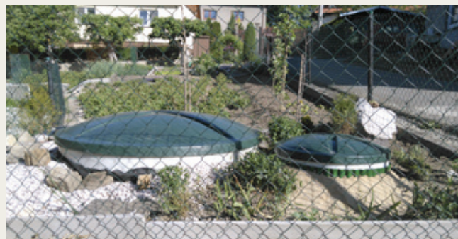
Domovní čistírna s technologickým blokem v obci Rybí ▲
