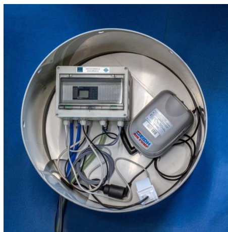
Příklad umístění řídící jednotky u ČOV
