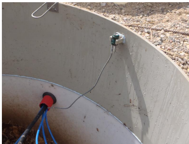
Příklad umístění čidla v ČOV
